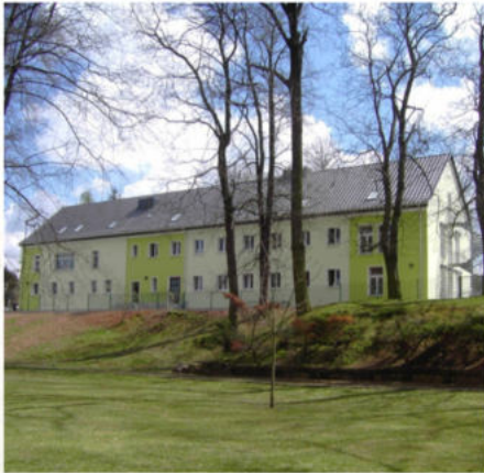
Abbildung 37: Sanierung Außenhülle Kita Regenbogen, Fraureuth
