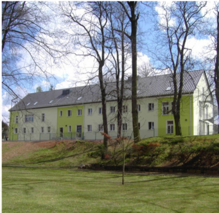
Abbildung 37: Sanierung Außenhülle Kita Regenbogen, Fraureuth
